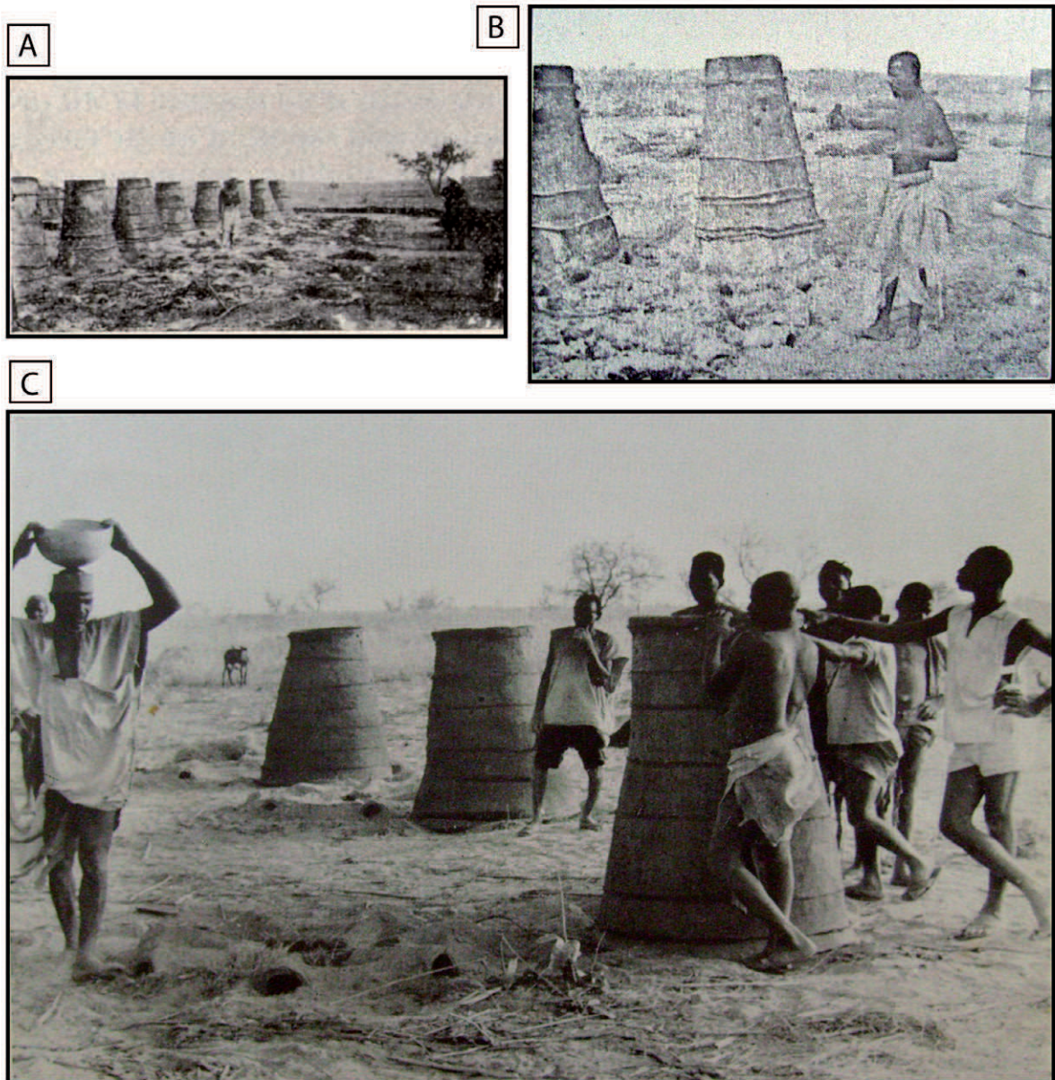
Figure I.36. Photographies de bas fourneaux à usage unique (20 e siècle).
