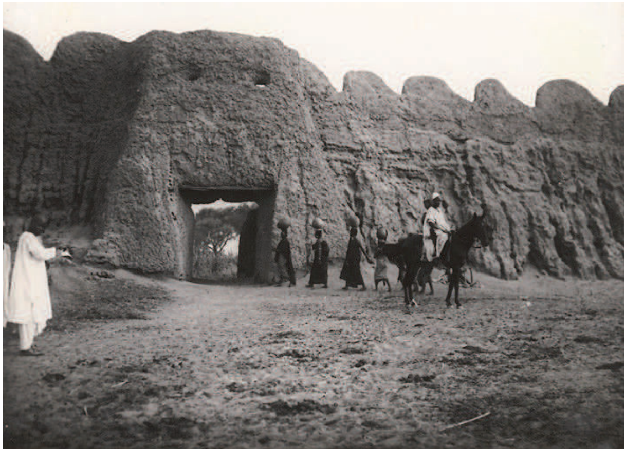
Figure I.31. Entrée du Birni du village fortifié de Zinder 1928-1930 (fond iconographique des Archives Nationales d'Outre-Mer ; cote FR CAOM 30Fi20/27)
