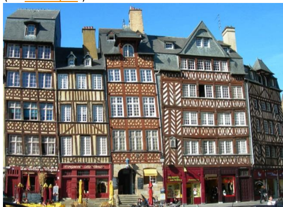
Figure 8 : Bâtiments multiétages à colombage à bois long et court
