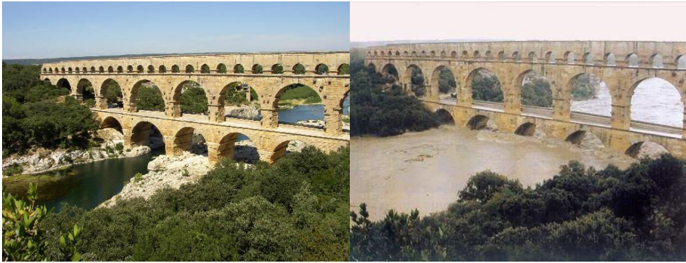
Figure A.1 – “Le pont du Gard” (©Yves Dequenne, oct. 2009) et le pont du Gard lors de la “Crue historique des Gardons le 9 septembre 2002” (©garinimes).
