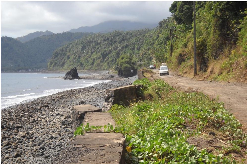
Photo 8-1: Murs soutenant les infrastructures routières contre l'érosion
