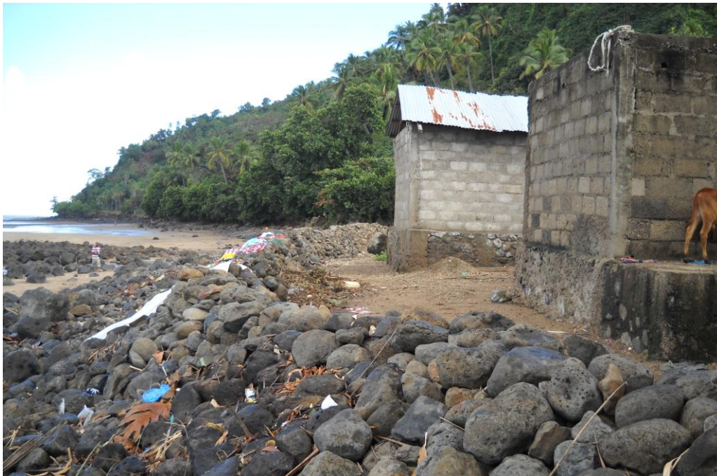
Photo 8-2: Enrochement chaotique contre l'assaut de la mer sur le trait de côte de M'Romouhouli (cliché : Kamardine M.Sinane, 2012)
