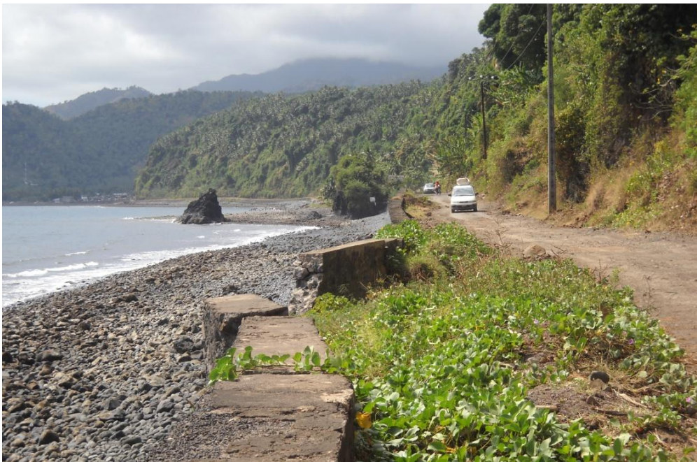
Photo 8-1: Murs soutenant les infrastructures routières contre l'érosion
