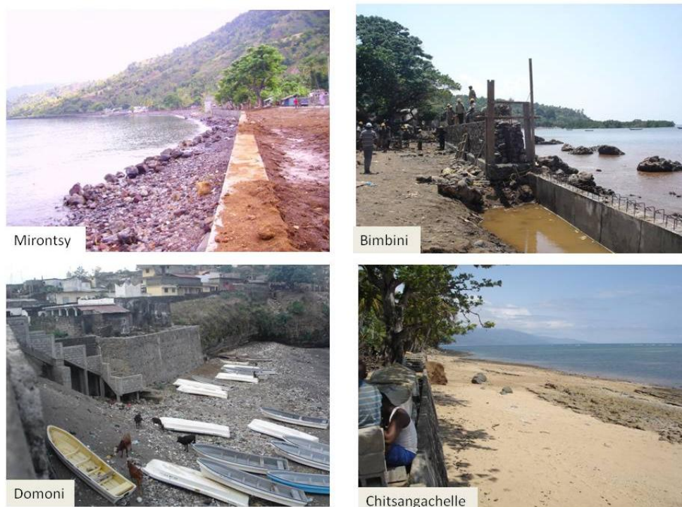
Planche photographique 8-1: Murs contre l'érosion côtière nouvellement construits (cliché : Kamardine.M.Sinane et Roland Troadec, 2009 )
