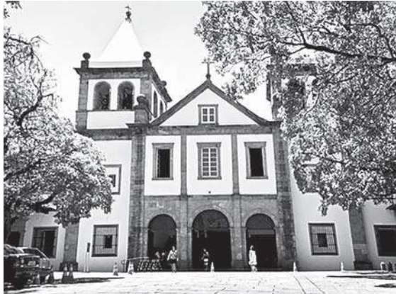
Mosteiro de São Bento (RJ)
