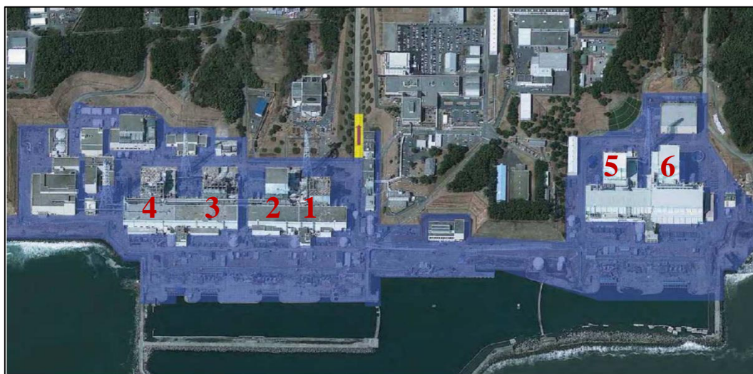
Figure I - 1-7 - Zone inondée suite au tsunami et localisation des 6 réacteurs (IRSN, 2012).
