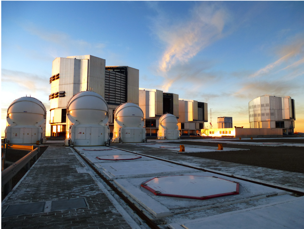
FIGURE 3.1 – L'observatoire du VLT, au sommet du Mont Paranal. Sur cette photo, on peut voir les 4 UTs, les 4 ATs (dans leur configuration la plus compacte), ainsi que le télescope VST (au fond). Au premier plan, on aperçoit les rails sur lesquels peuvent se déplacer les ATs et différentes positions qu'ils peuvent occuper.
