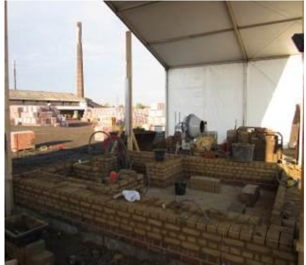
Murs épais en briques de terre crue
