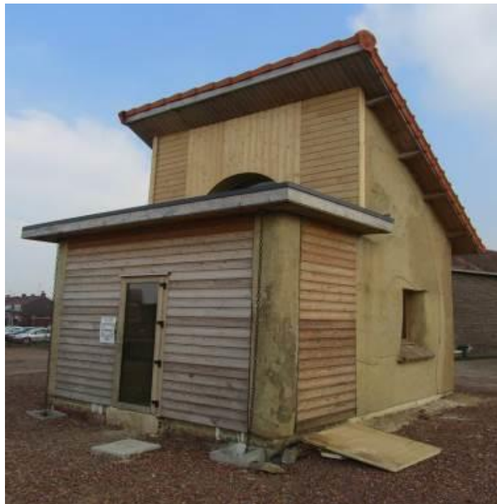
Figure 3.22. Bâtiment expérimental du projet «Terre en Nord»
