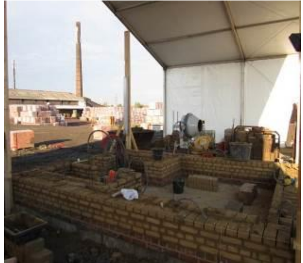
Murs épais en briques de terre crue
