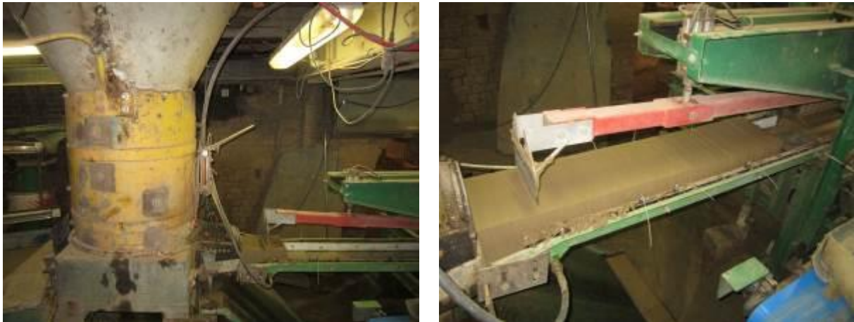
Figure 3.5. Extrusion des briques de Leers
