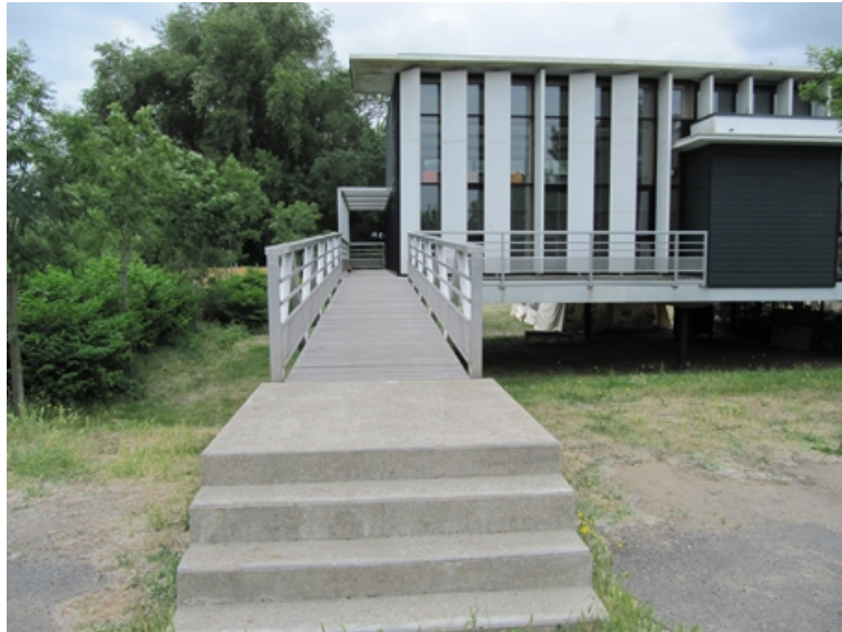
Image 16 : Seconde Passerelle au Nord du bâtiment
