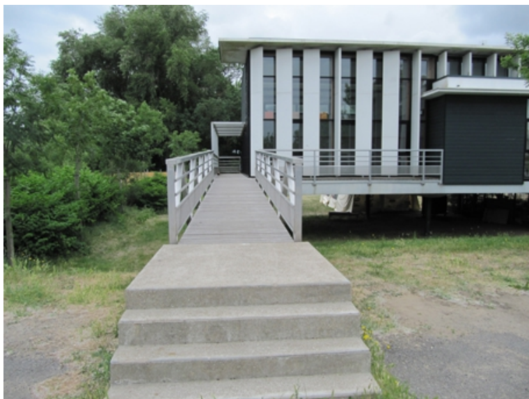
Photographie : Seconde Passerelle au Nord du bâtiment
