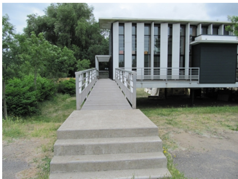
Photographie : Seconde Passerelle au Nord du bâtiment
