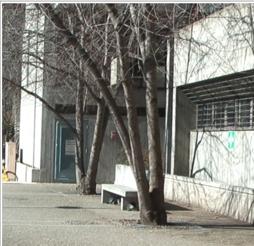
Photographie montrant le dispositif installé sur le site
