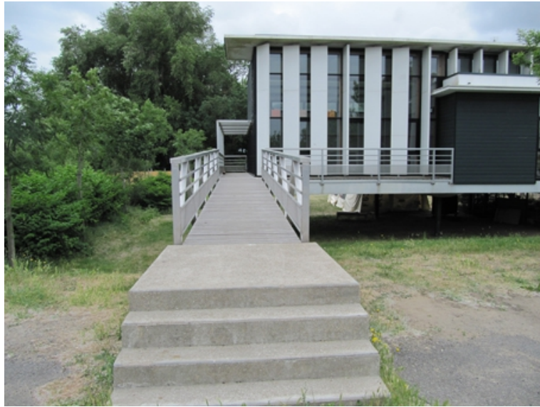
Image 16 : Seconde Passerelle au Nord du bâtiment
