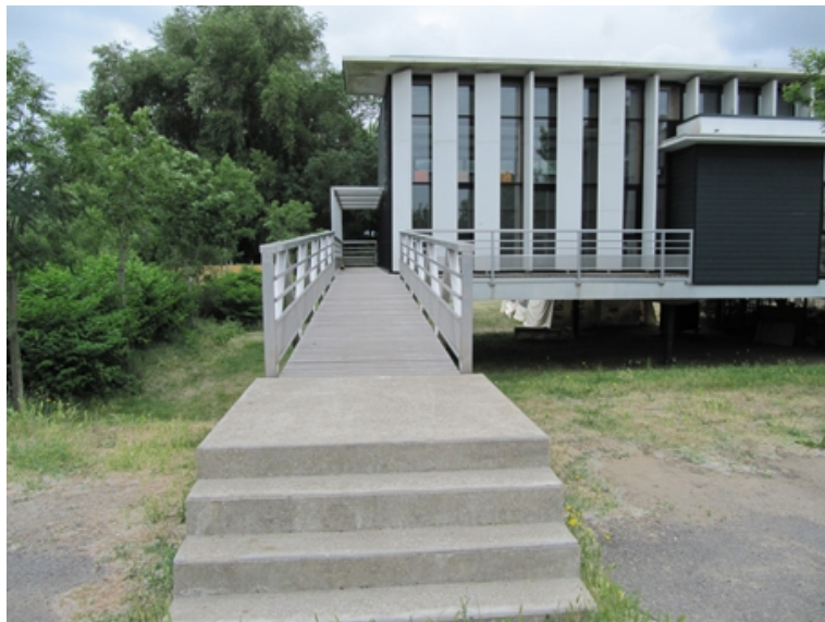
Image 16 : Seconde Passerelle au Nord du bâtiment
