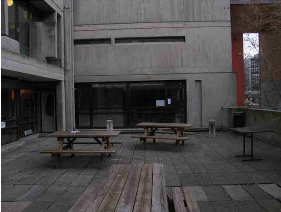
Image14: Terrasse Sud ENSAG-entrée hall entrée
