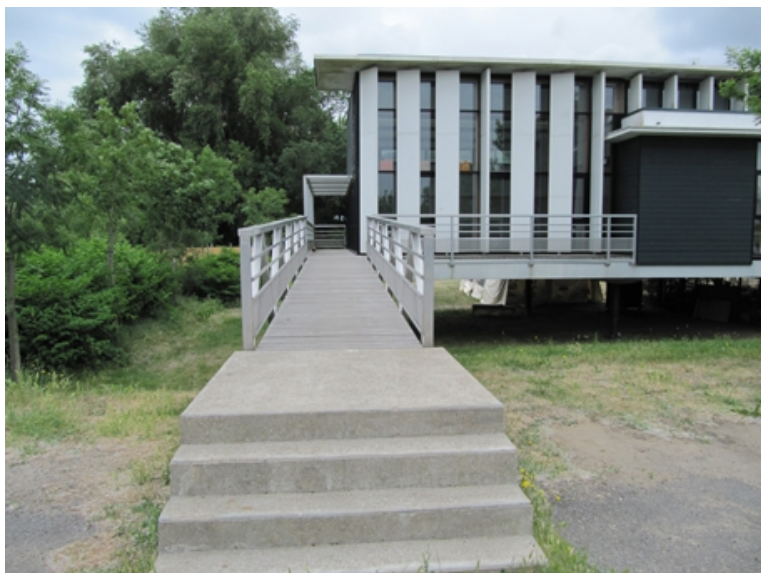
Photographie : Seconde Passerelle au Nord du bâtiment
