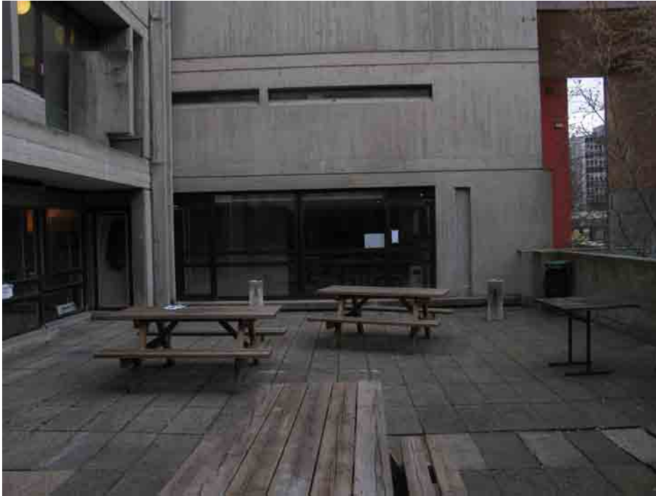
Image14: Terrasse Sud ENSAG-entrée hall entrée
