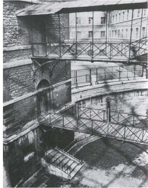
2.7. Petite Roquette. Passerelles métalliques reliant les ailes radio-concentriques à la tour centrale. Bruno Foucart, « Architecture carcérale et architectes fonctionnalistes en France au XIX e siècle », Revue de l'art , n°32, Paris 1976
