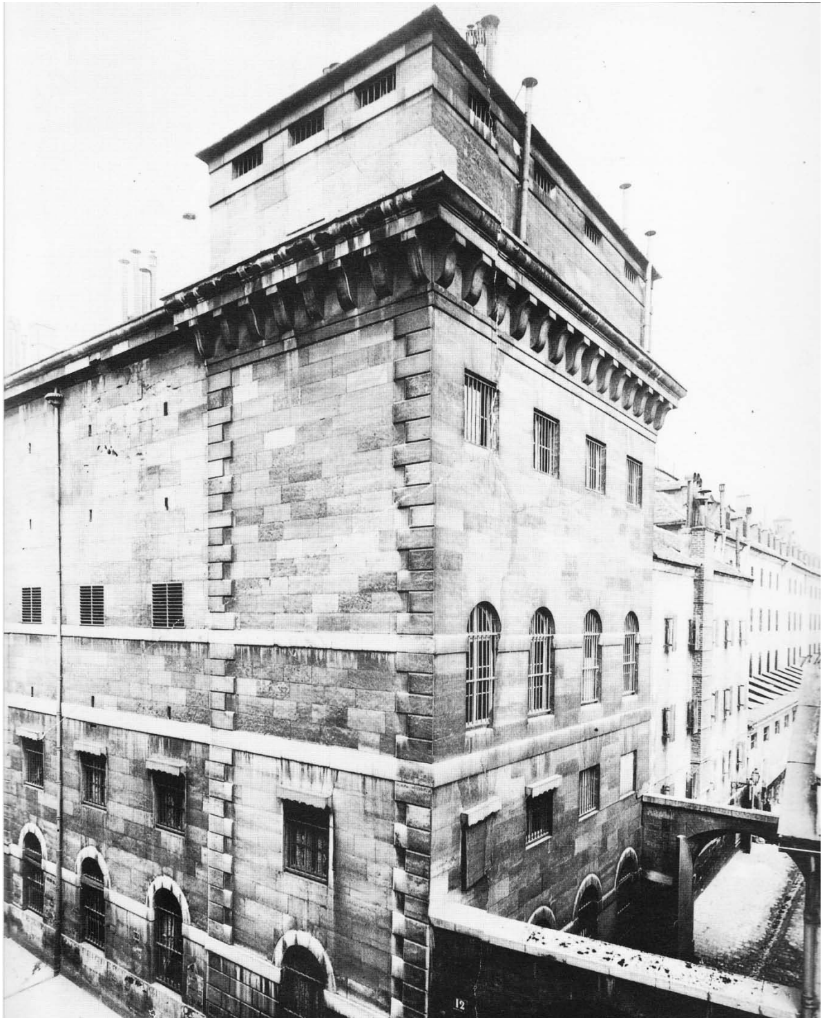
Façade de la prison sur la rue du Puits-de-l'Hermitte, 1824, photographie ancienne. Bibliothèque Nationale de France, département des Estampes, Va 257 g, Paris/photo BNF
