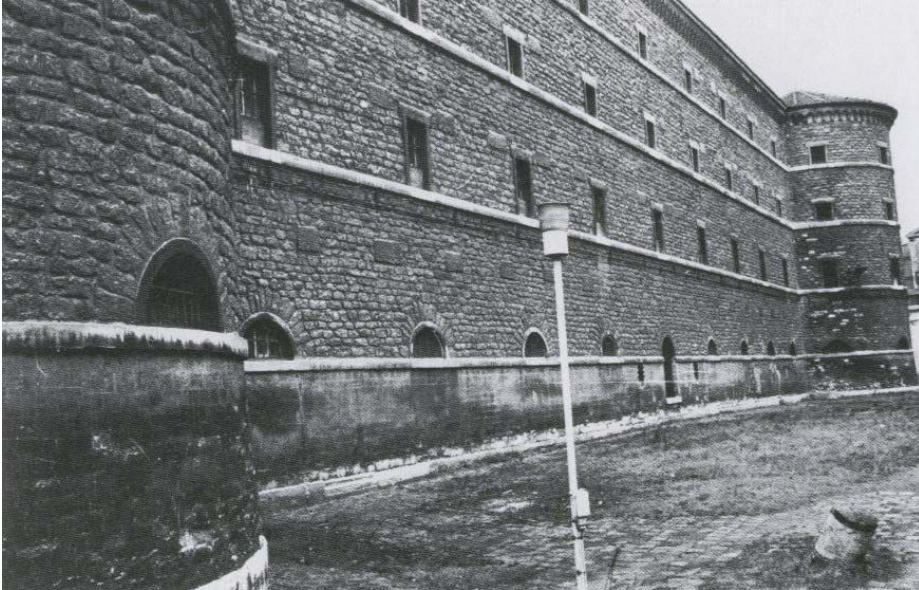
2.3. Hippolyte Lebas, Prison de la Petite Roquette, 1826 – 1836, détruite en 1974. Façade extérieure avec baies éclairant les couloirs.
