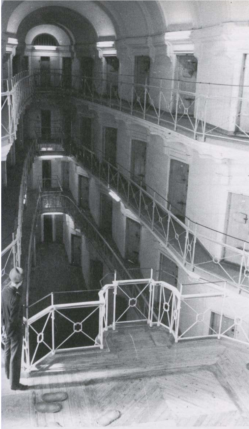
Harou-Romain, dit le fils, Maison centrale de Beaulieu à Caen. Quartier cellulaire. Après 1844. Vue prise de l'emplacement de l'autel sur la tour de surveillance.
