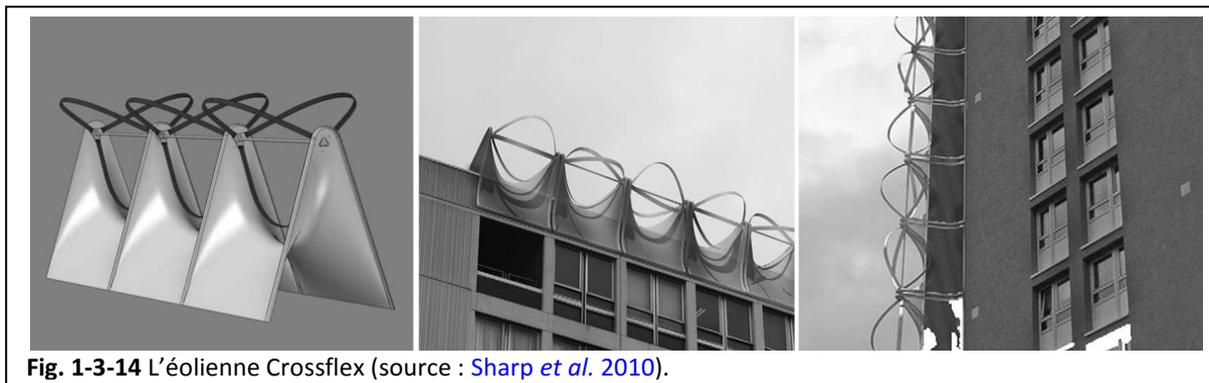
**Fig. 1-3-14** L'éolienne Crossflex (source : [Sharp et al. 2010](#)).
