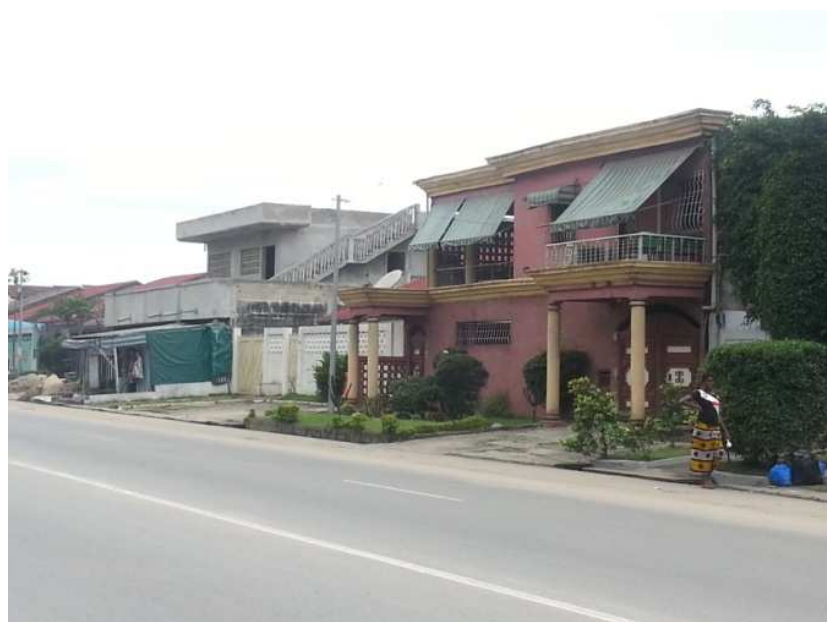
Vue de villas de plain-pied de l'opération Caféier 6 de la SIPIM transformées en de villas duplex
