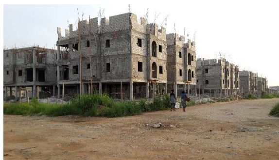
Chantier du projet des agents du Trésor
