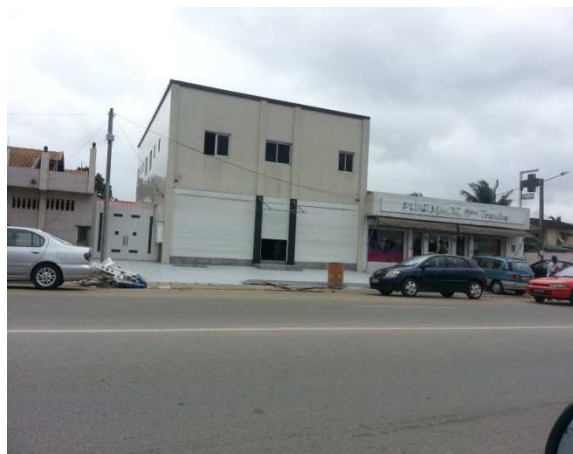
Transformation de villas d'une opération immobilière en pharmacie et bureaux, à Cocody, 8 ème Tranche
