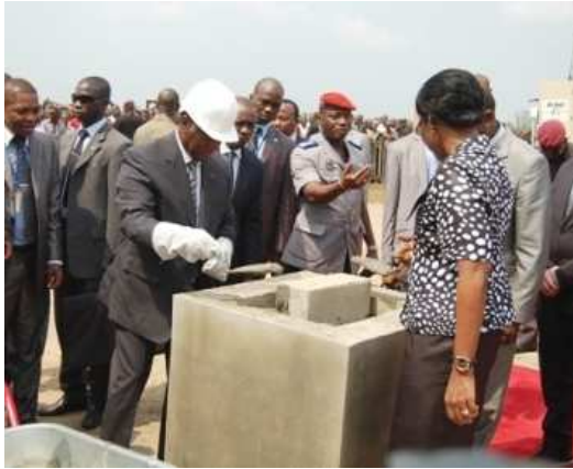
Vue de la pose de la première pierre par le Président de la République sous le regard de la Ministre en charge du Logement en janvier 2012 à Yopougon
