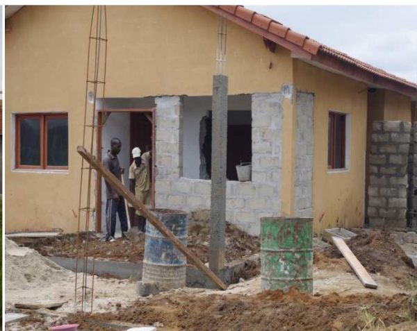
Modification en cours d'une villa basse. Cette modification porte sur l'agrandissement du séjour et l'adjonction d'une terrasse plus grande
