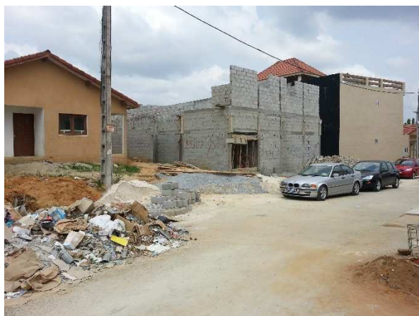
Cette vue prise en janvier 2014 montre la progression du chantier malgré l'intervention du Ministère de la Construction et le défaut de permis de construire
