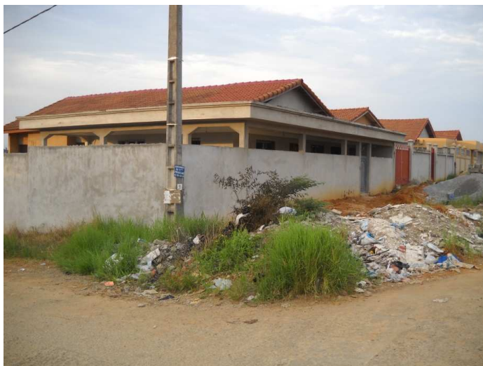
Cette image montre l'érection de clôtures et l'adjonction d'une terrasse plus grande à la villa type initial d'une opération immobilière à Cocody.
