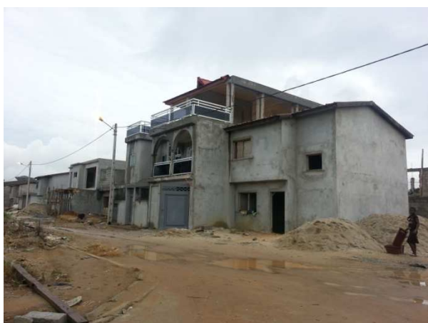
Modification en cours de la villa duplex avant son occupation
