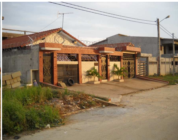
Cette image montre l'érection d'une clôture de plus de 2m de haut, avec des portails métalliques
