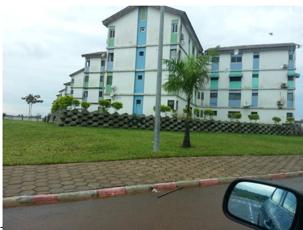
Un immeuble collectif du programme immobilier des agents de la SIR. Ce programme comporte plusieurs types de logements : villas, duplex, immeuble
