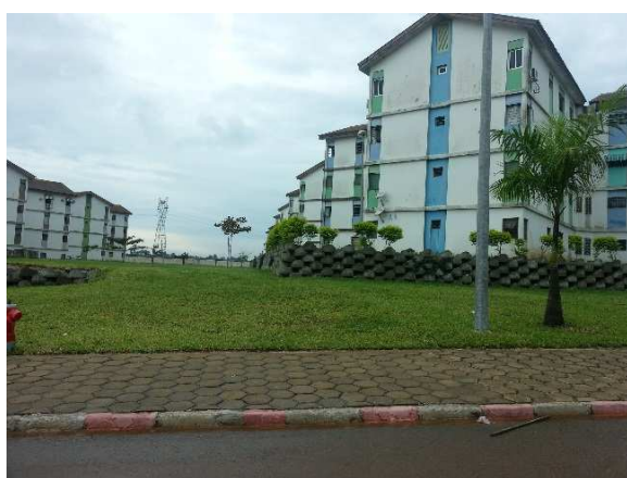
Une vue de l'opération des agents de la SIR à la Riviera (immeuble de R+3)
