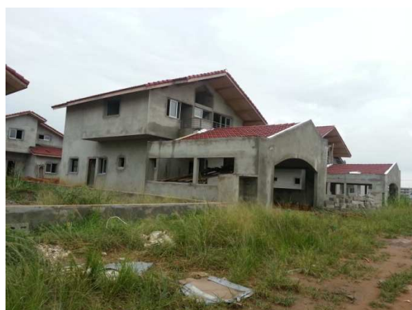
Une villa duplex de standing en construction dans un programme destiné aux pharmaciens à Cocody Riviera. Il est composé uniquement de villas duplex.
