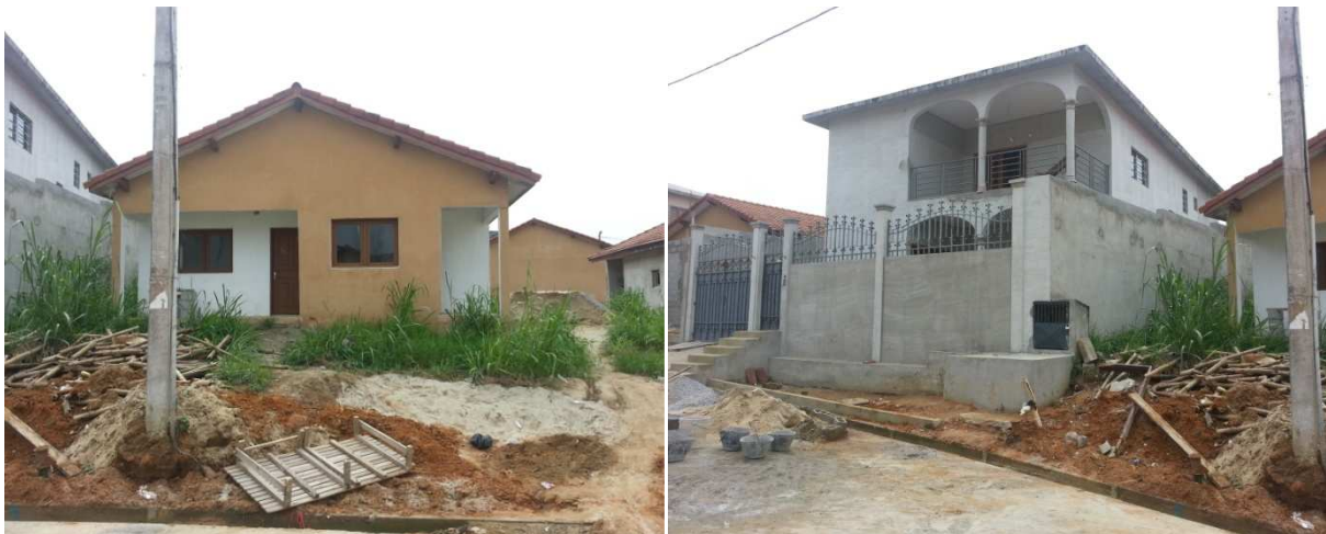
Villa basse avant modification dans l'opération immobilière Star 13, à la 9 ème Tranche, commune de Cocody.
