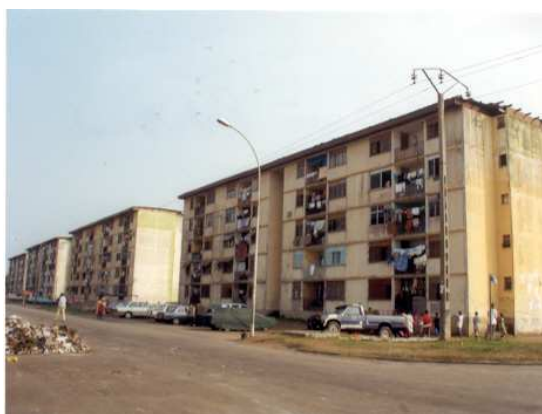
Le cliché montre des immeubles produits par la SOGEFIHA dans la commune de Port-Bouet : Cité Policière de Vridi
