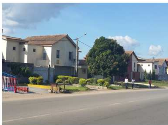
Vue de villas duplex de l'opération Djibi 3 de la SICOGI avant modification, à Cocody 8 ème Tranche
