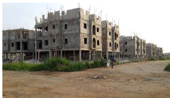
Chantier du projet des agents du Trésor
