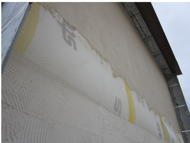
FIGURE 2.9 – Structure de l'enduit
