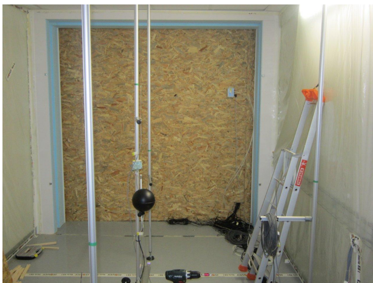
FIGURE 2.10 – Pose des plaques d'OSB
