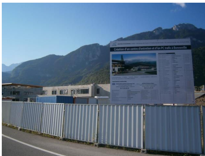
Photo 1 : Chantier du centre d'entretien et de contrôle trafic de Bonneville Cliché : A. Merle, août 2013
