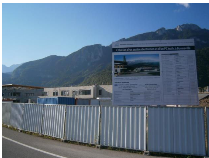
Photo 1 : Chantier du centre d'entretien et de contrôle trafic de Bonneville Cliché : A. Merle, août 2013
