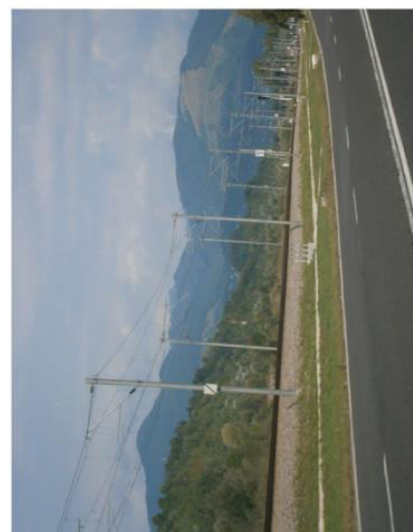
Photo 22 : La voie ferrée Ploiesti-Brasov : une voie double électrifiée refaite entièrement en 2012-2013, sur fonds européens essentiellement. Les caténaires, les rails et le ballast sont neufs.
