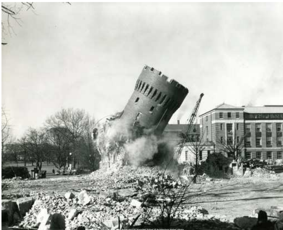
Figure 88. En haut, l'ancienne caserne. En bas, la démolition de la caserne pour céder place au campus.
