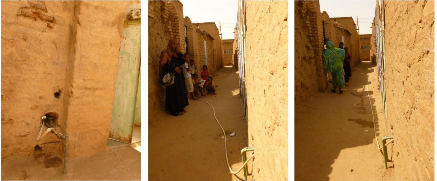
PHOTOS 17, 18, 19. **LE BRICOLAGE DE SHAZA** : la première photo illustre la fixation temporaire du tuyau sur l'arrivée d'eau du voisin dans la cour. La deuxième photo montre, du côté de la ruelle, le tuyau qui entre dans la maison de Shaza. Dans la troisième photo, le tuyau transfère quelques heures plus tard l'eau à la maison de Samira.
