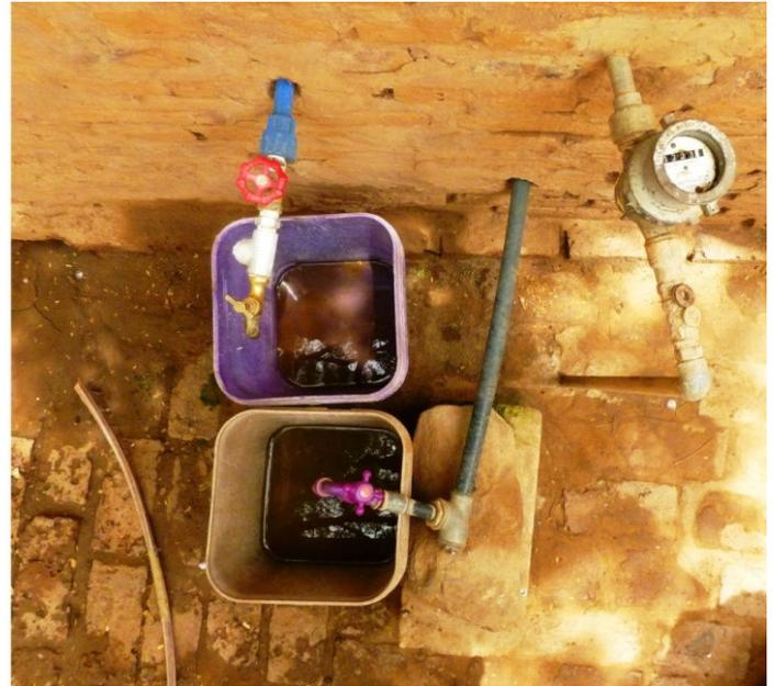
PHOTOS 26 et 27. **LES TROIS RESEAUX DANS LES MAISONS DE TUTI** : Le tuyau en fonte (au milieu dans la première photo, à droite sur la deuxième) date des tentatives de mise en réseau des années 1960 et ne fonctionne plus. Le tuyau gris (première photo) ou vert (deuxième photo) a été installé avec la construction de la station de pompage en 1984. Le tuyau vert (première photo) ou bleu (deuxième photo) a été mis en place en 2010 par la compagnie Stilit. Septembre – Décembre 2011. L. Arango
