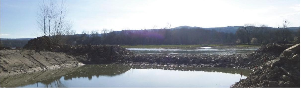
**Figure 6.3. Arasement de la digue submersible contrôlant la fréquence de connexion amont de la lône de la Platière sur le vieux-Rhône du Péage-de-Roussillon (mars 2014).**
