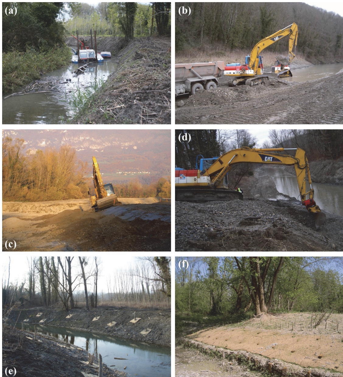
Figure 2.6. Exemple de techniques de génie civil et de génie végétal mises en œuvre pour la restauration des bras. (a) Curage de la lône Moiroud à l'aide d'une drague aspiratrice (cliché CNR). (b) Excavation de la partie amont de la lône Fournier à la pelle mécanique. (c) Exemples de recalibrage de berges sur la lône du Brotalet (cliché G. Mergoud) et (d) de Fournier (cliché G. Mergoud). (e) Exemples de pratiques de génie végétal sur les lônes de Moiroud (cliché M. Michalková) et (f) de la Malourdie (cliché G. Mergoud).
