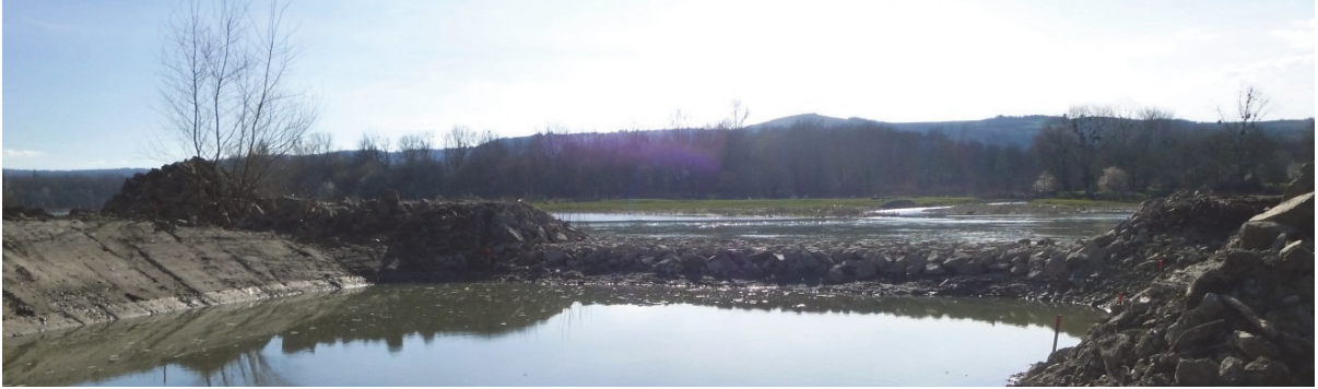
Figure 6.3. Arasement de la digue submersible contrôlant la fréquence de connexion amont de la lône de la Platière sur le vieux-Rhône du Péage-de-Roussillon (mars 2014).
