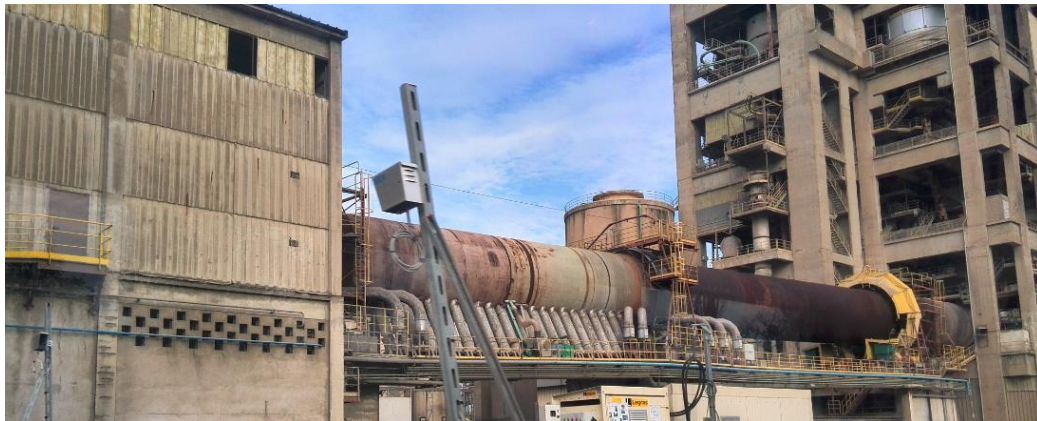
Figure I-12 Four rotatif de la cimenterie Lafarge de Saint-Pierre-La-Cour utilisé pour la fabrication du clinker.
