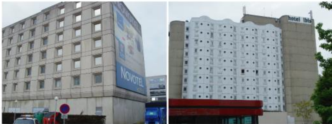
Les immeubles hôteliers : Novotel et Ibis du Roissy-pôle
