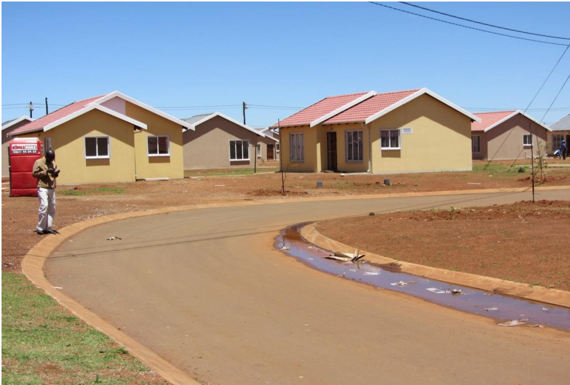
Figure n°23, une rue de l'extension 28 récemment construite, Proeta Glen, source : auteur, cliché pris en février 2013.
