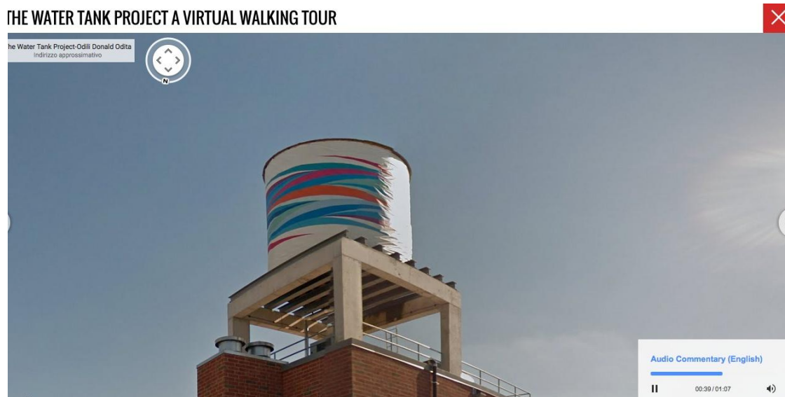
Fig. 92 - L'immagine è navigabile con il sistema Street view; si può zoomare e ruotare attorno al serbatoio nella foto arrivando a metterne a fuoco dettagli che potrebbero non essere colti dalla visione in strada; allo stesso modo l'azione limitata (non si può fare esattamente tutto ciò che si vuole) invece che dare rilievo allo spazio circostante finisce per riportare l'opera in uno spazio altro, smaterializzato, bidimensionale.
