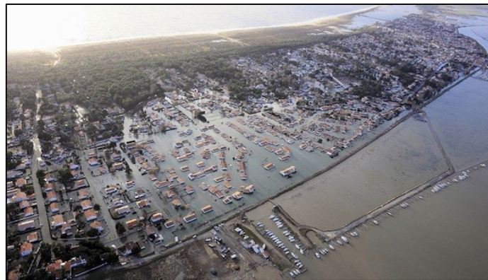
Photo II.9 La Faute-sur-Mer inondée suite à la tempête Xynthia (Source : Crédit photo PQR/Ouest France)
