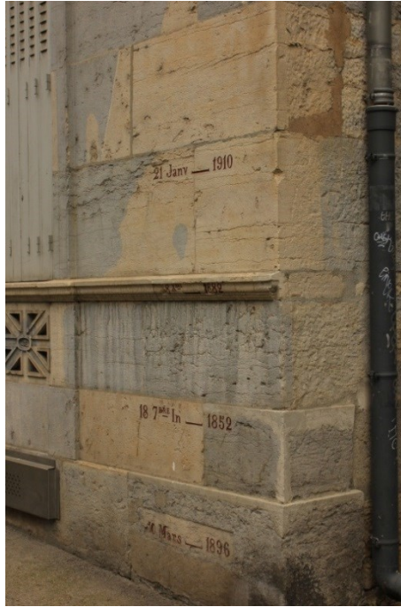
Photo VI.1 Marques de repères de crues dans le centre-ville de Besançon (Source : Photographie personnelle, mai 2014)
