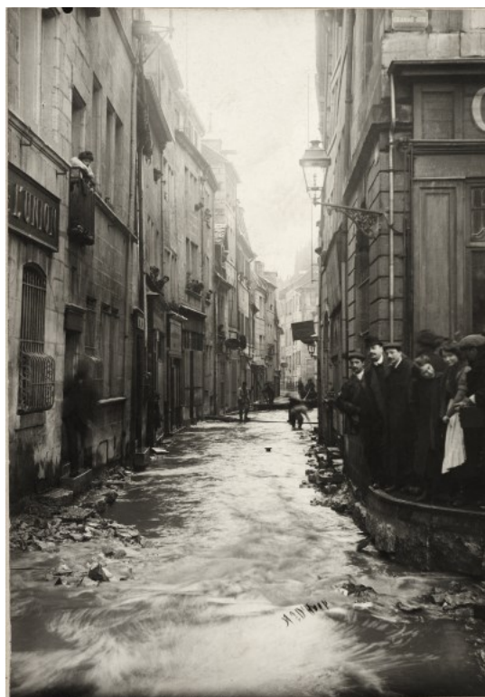
Photo II.1. L'inondation de janvier 1910 dans les rues de Besançon (Source : DREAL Doubs)
