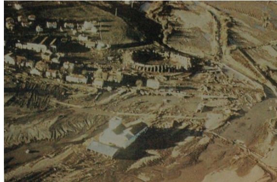
Photo II.5 Le quartier des arènes de Fréjus après le passage de la vague (Source : Donnât, 1990)
