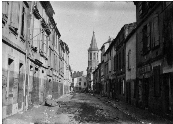
Photo II.2 Le quartier de Sapiac à Montauban après les inondations de mars 1930 (Source : fonds photographique DDE82)
