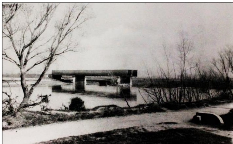
Photo III.1 Le Pont Cacor après la crue à Moissac (Source : AD Tarn-et-Garonne Série Fi, 3Fi 52)
