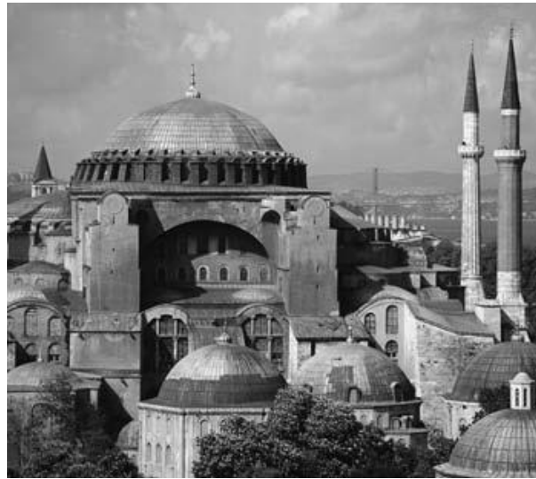
Fig. 2.15. Exemplu de structură arhitecturală [Wells, 2010].
