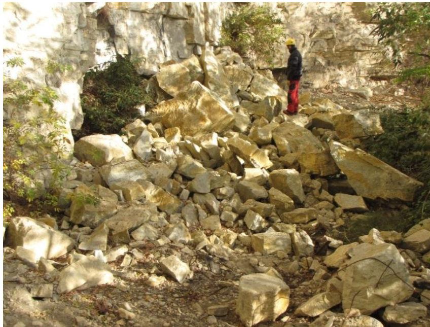
Figure 2.14. Photo d'un ancien éboulement de petit volume (dépôt d'environ 200 m 3 )
