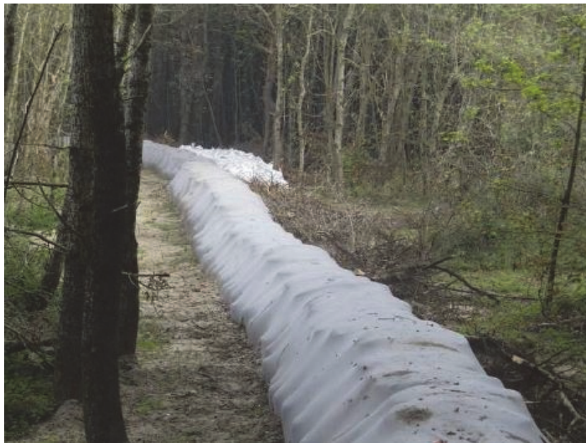
Fig. V-253: Barrage de sacs d'1 m 3 remplis de sable et recouvert de géotextile au sein du Bois de Sapins (Cliché pris par l'association ADCMBA)
