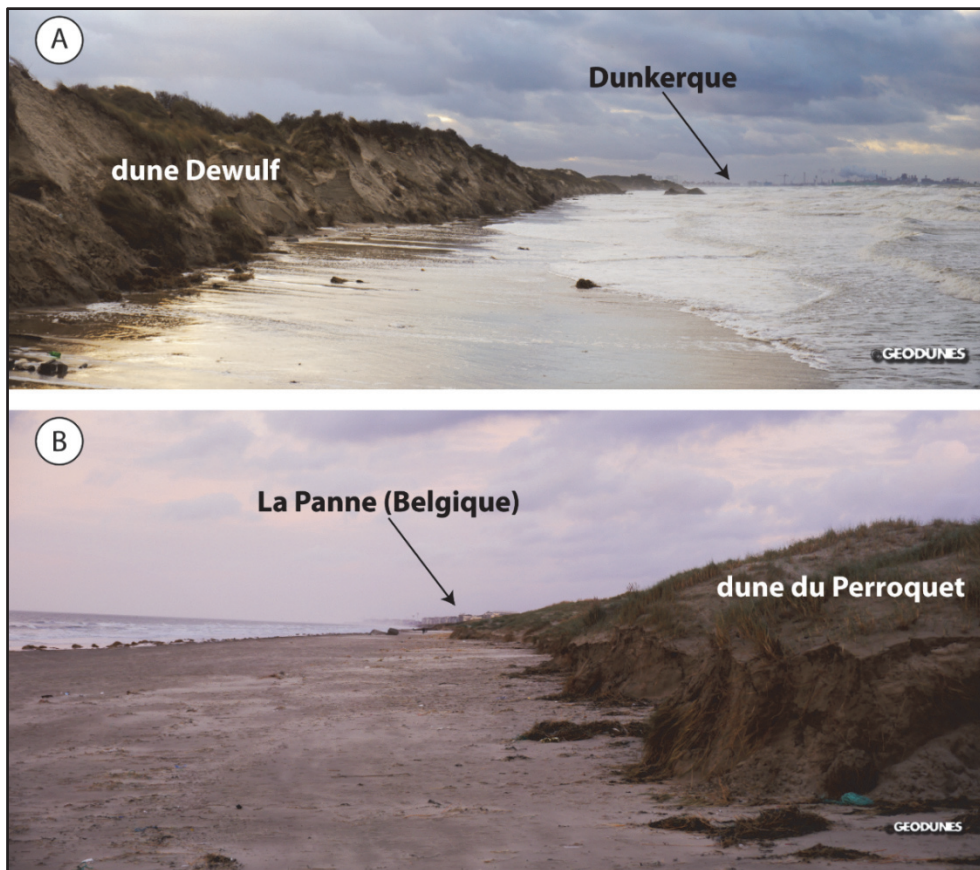
Fig. III-132 : Illustration de l'érosion du front dunaire de la dune Dewulf (A) et de la dune du Perroquet (B) suite au passage de la tempête Xaver en décembre 2013 (clichés pris le 08/12/2013 par Adrien Cartier).
