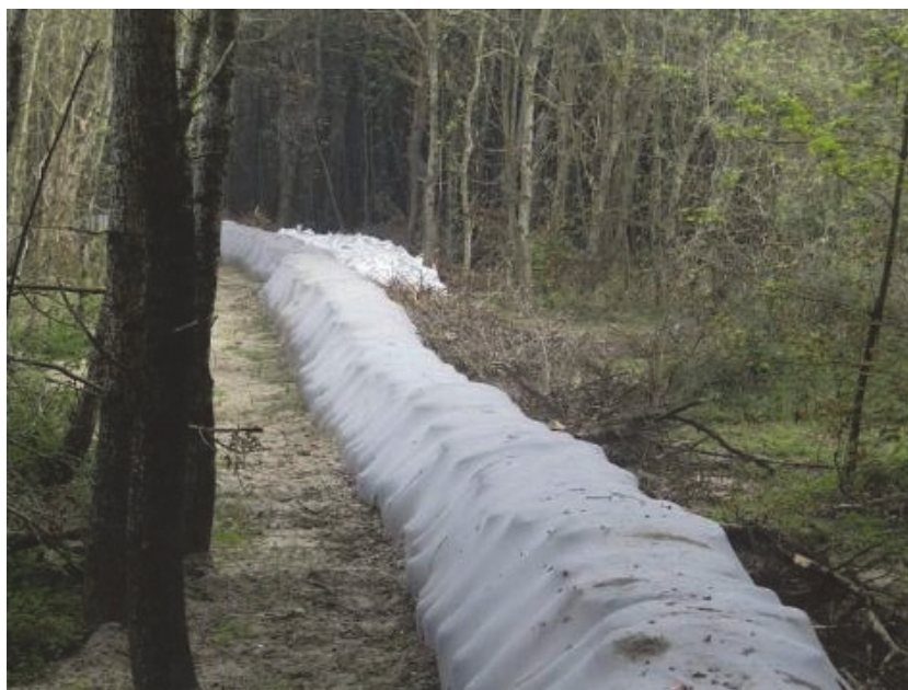
Fig. V-253: Barrage de sacs d'1 m 3 remplis de sable et recouvert de géotextile au sein du Bois de Sapins (Cliché pris par l'association ADCMBA)
