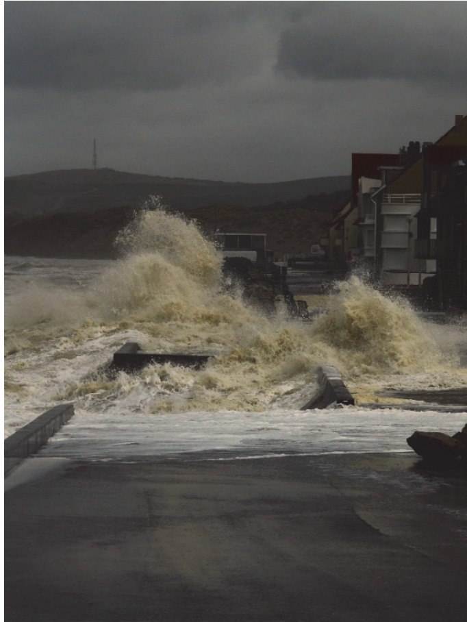
Fig. V-246: Submersion de la digue de Wissant lors de la tempête du 31/10/2013. (Cliché pris par Adrien Cartier).
