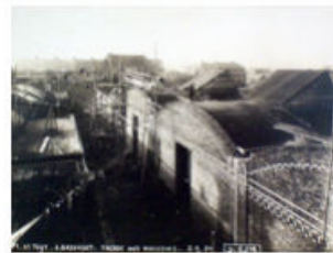
Reconstruction de l'usine à partir de 1921 (source : A.M.A.)
