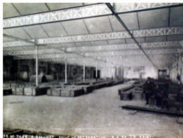
Salle de préparation de l'usine en 1921 (source : A.M.A.)
