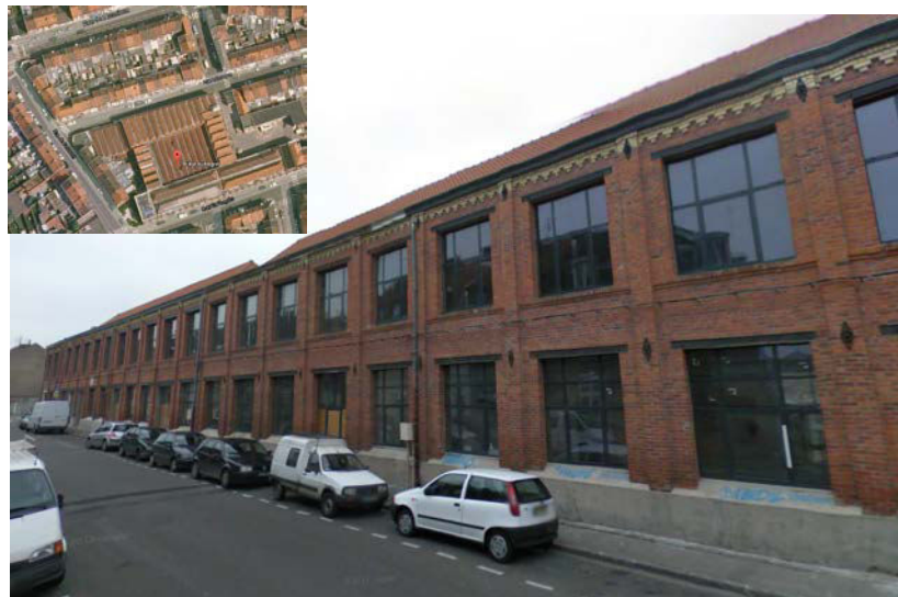
18. Façade sud de l'ancien tissage Bouchez en 2013 transformé en Loft
