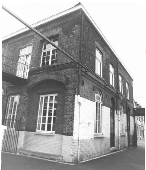
38. Filature Mahieu Ancien atelier de fabrication en 1977 : vue et vue de l'Ouest (Source : Mérimée)
