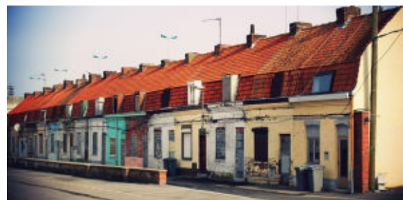
6. Maisons ouvrières d'Armentières en 2006 (Source : A.M.A.)
