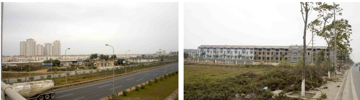
Figure 10.2.2.a : Quelques projets de KDTM (image à gauche : la KDTM An Khanh du Nord - Splendor, image à droite : la KDTM Geleximco - Le Trong Tan) le long de l'avenue Thang Long à l'ouest de Hanoi (au district Quoc Oai de la province Ha Tay ancienne)
