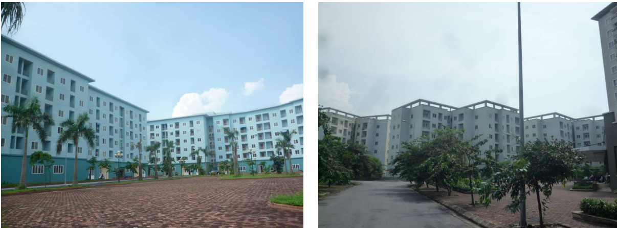
Figure 10.1.1.b15 : Les immeubles de 6 niveaux de logement social à la KDTM Viet Hung
