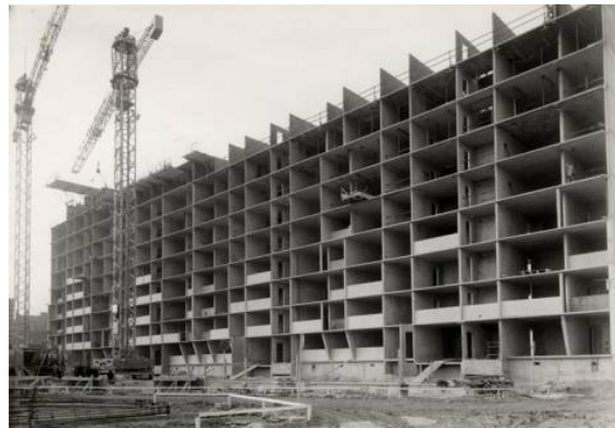
Figure 6.2.1.e2 : La technique de grue sur rail permet de construire vite les immeubles des grands ensembles
