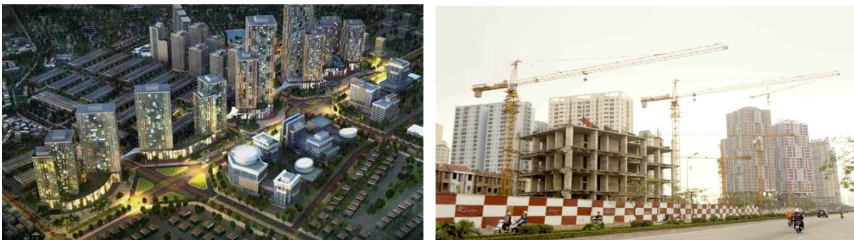
Figure 10.2.1 : Le projet de KDTM Usilk City (un sous-projet d'expansion de la KDTM Van Khe) dont l'achèvement prévu au mois de 12/2013 et l'état de lieux au mois de 02/2014 : la prolongation de la construction causée par les difficultés concernant les financements des acteurs
