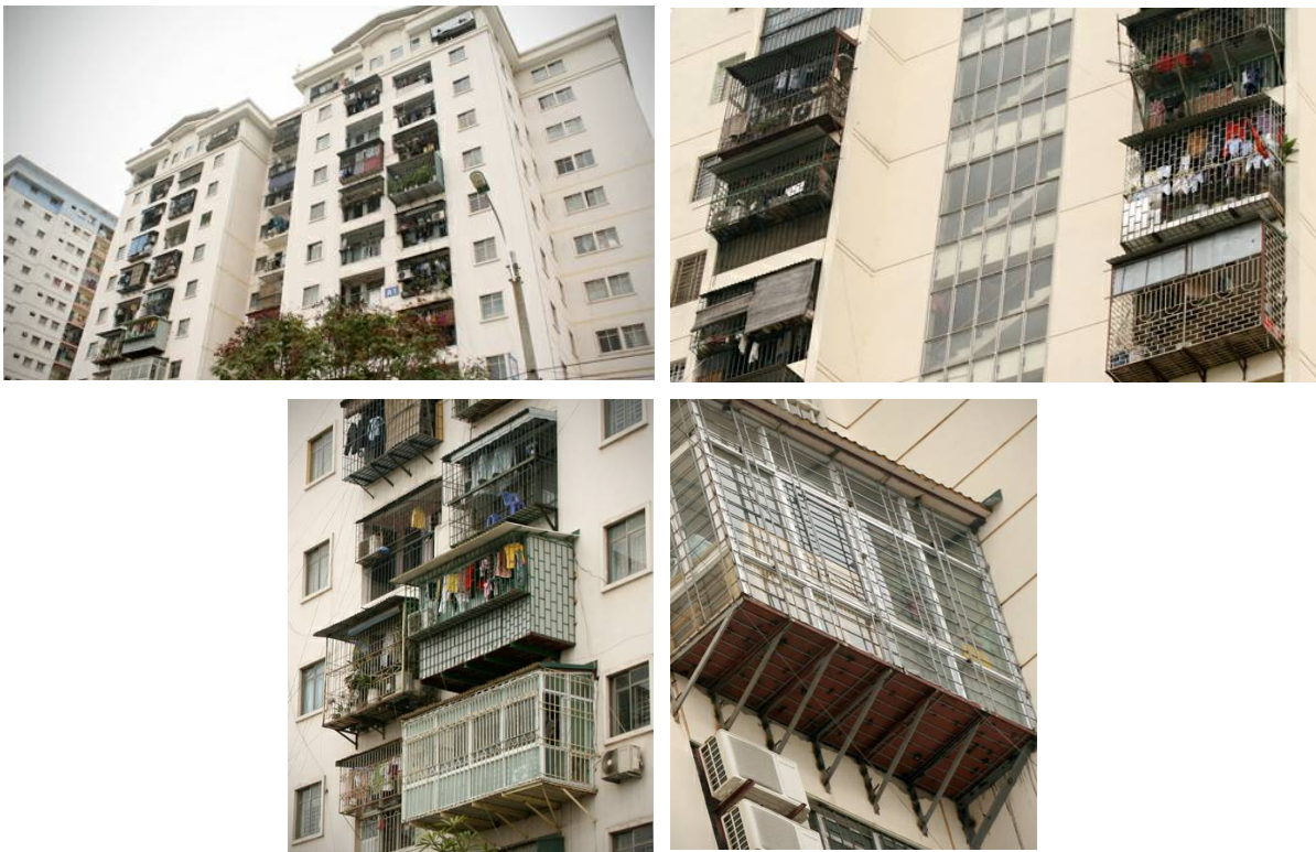
Figure 10.4.1.a : Les « cages à tigre » aux immeubles de la KDTM Den Lu 1 et 2
