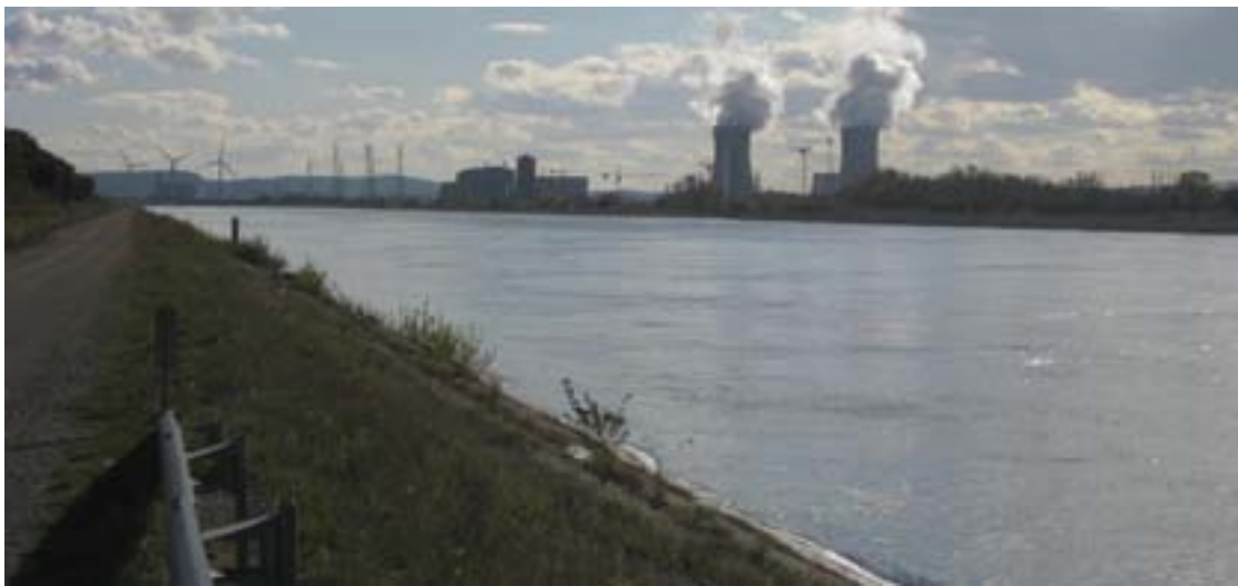
Figure 7 : Photographie du canal de dérivation de l'aménagement de Donzère-Mondragon (CNR).
