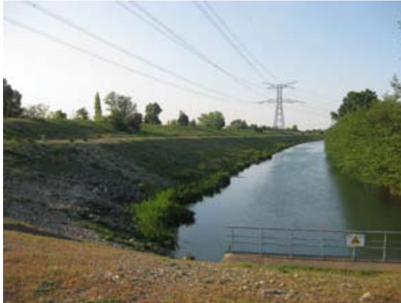
Figure 9 : Photographie de la digue CNR à Piolenc et du contre-canal.
