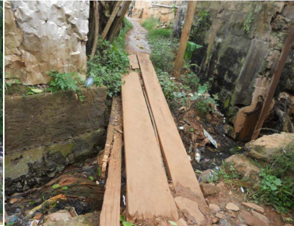
B : Pont de singe pour la traversée d'un ruisseau à Melen
