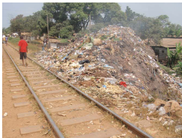
B : Monticule de déchets sur la voie ferrée Yaoundé-Ngaoundéré
