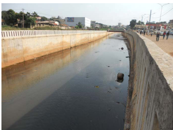
C. Ouvrage construit pour palier aux inondations au Centre ville
