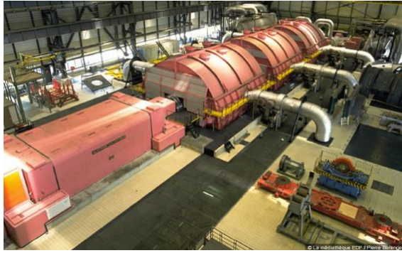
FIG. 1.1: Groupe Turbo-Alternateur en centrale
