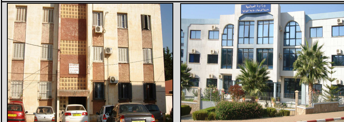
Photos -33- et -34- Malgré le climat clémente de la région, la climatisation électrique se généralise. Les « climatiseurs » sont rajoutés dans les bâtiments anciens comme au niveau de cet immeuble d'habitat, datant du début des années 1980 (à gauche), et font partie intégrante des nouvelles constructions, comme sur cette façade de la nouvelle direction des finances. Photos Bachar k. 2012/ 2013
