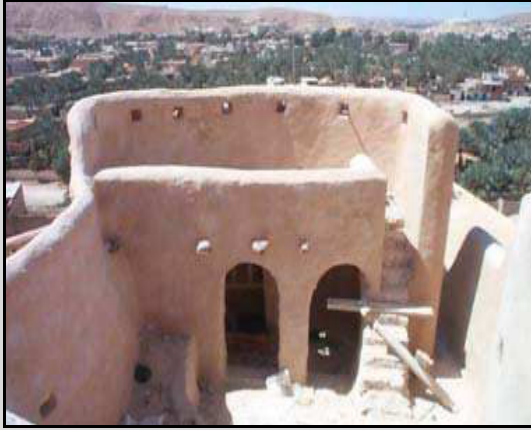
Photo -87- Ouvrage hydraulique de la vallée du M'zab
