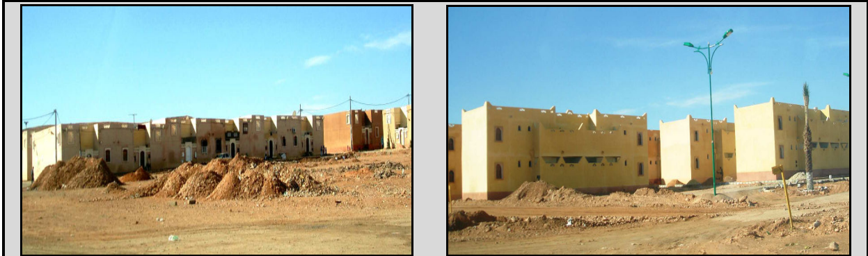
Photos -120- et -121- Juxtaposition répétitive de bâtiments identiques, sans aucune présence de verdure, qui viendra (peut-être) bien après, comme élément d'aménagement complémentaire.
