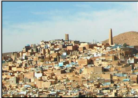
Photo -94- Vue du ksar et ses constructions étagées Photos Bachar k. 2013
