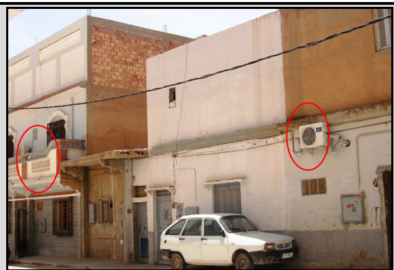
Photo -40- La climatisation se généralise Photos Bachar k. 2014
