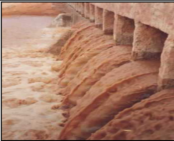
Photo -89- Système de partage des eaux
