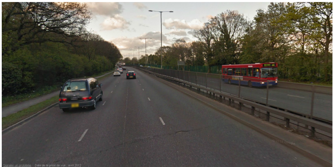
Figure 36 Vue de la North Circular à Finchley – trois voies par direction 120
