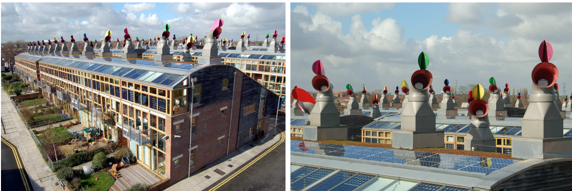
Figure 1.12 – Ventilation naturelle assistée par des extracteurs, quartier BedZED au sud de Londres
