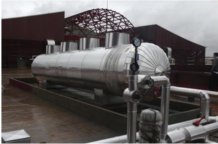
**Figure II-54 : Prototype de stockage pour une installation de refroidissement solaire construit sur le toit de l'université de Lleida en Espagne [109]**
