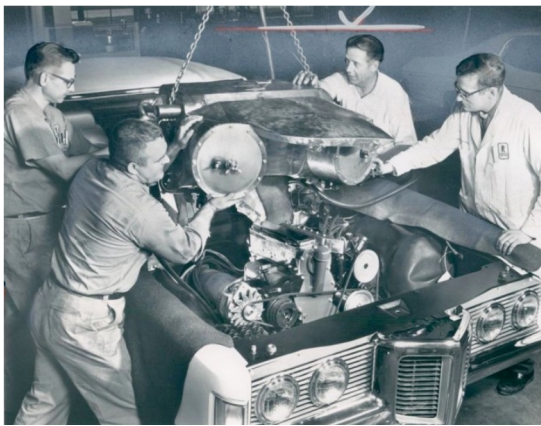
(a) Techniciens installant un générateur de vapeur sur une Pontiac Grand Prix 1969 [Strohl 2013]
