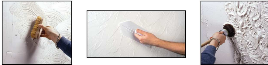
Figure 2.23 – Exemples d’application d’enduits sur un mur [75]
