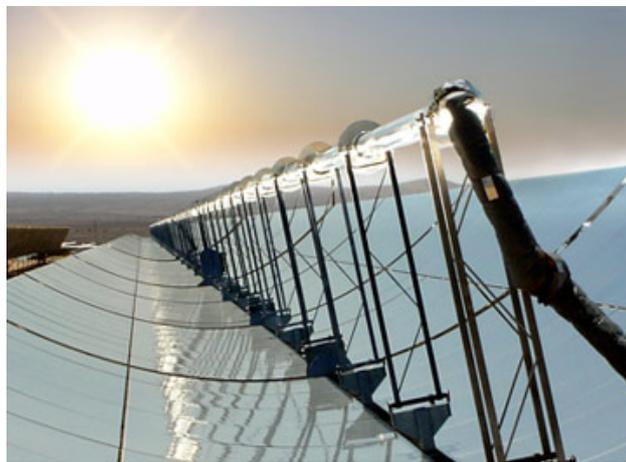
FIGURE 3.4 – Capteurs cylindro-paraboliques (Nevada Solar One)
